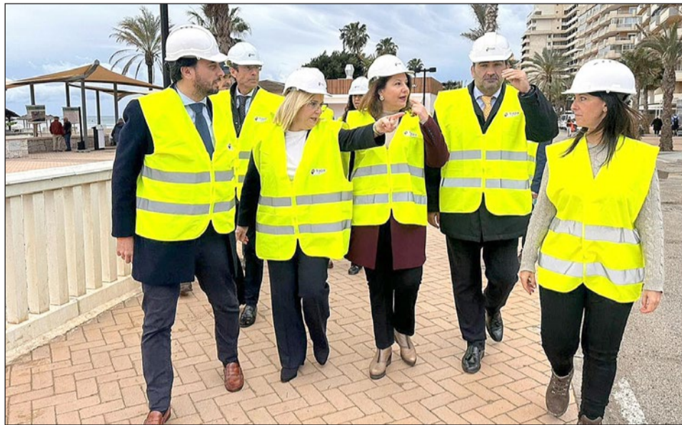
Ana Mula y Carmen Crespo durante su visita a las obras de saneamiento en el Paseo Marítimo de Torreblanca.
