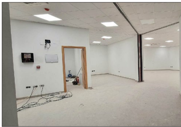
Las obras podrían concluir antes del verano.
